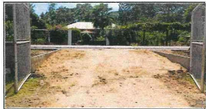
Foto 6: Relleno y Sustitucion de Cuneta de Concreto
