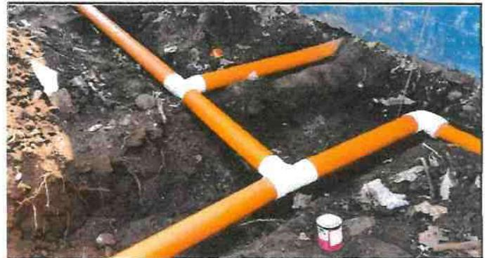
Foto 4: Instalacion de Bio Degestor: Instalacion de Tuberia de los baños existentes hacia el biodegestor
