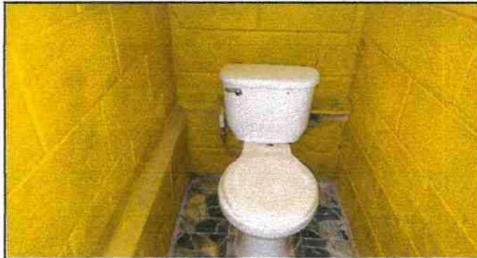
Foto 3: Instalación de azulejo en módulo de baños
