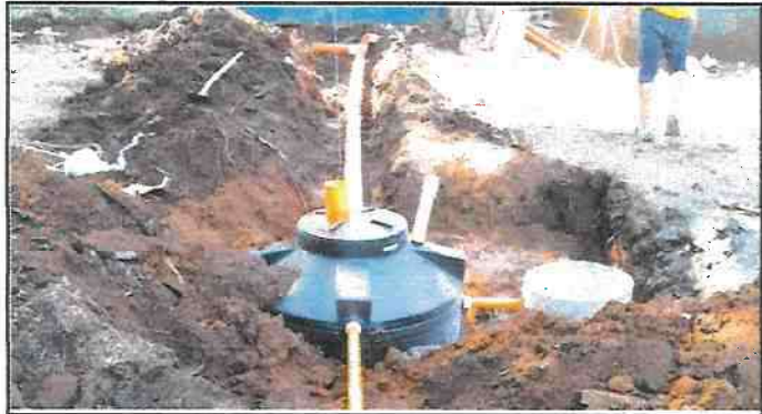
Foto 3: Instalacion de Bio Degestor para uso de baños lavables
