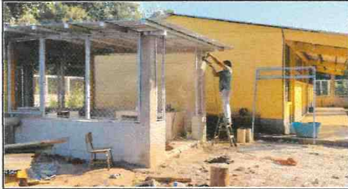
Foto 1: Mejoramiento de Cocina, Construcción de Estufa Rural
