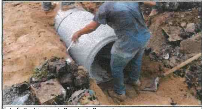
Foto 5: Sustitucion de Cuneta de Concreto
