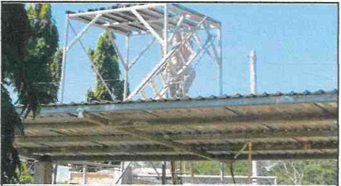
Foto 2: mejoramiento de suministro de agua, Refuerzo en estructura metalica
