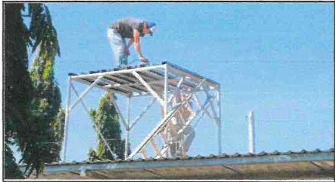
Foto1: mejoramiento de suministro de agua, cambio de Rotoplas
