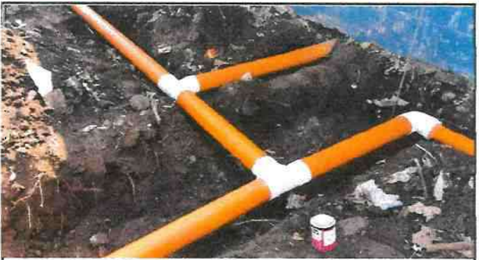
Foto 4: Instalacion de Bio Degestor: Instalacion de Tuberia de los baños existentes hacia el biodegestor
