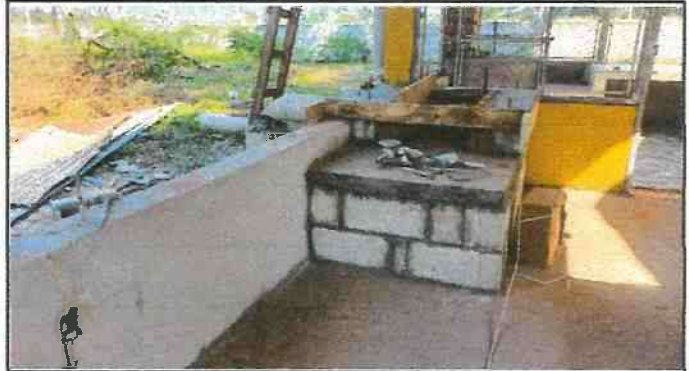
Foto 2: Mejoramiento de Cocina: suministro e instalación de piso antideslizante
