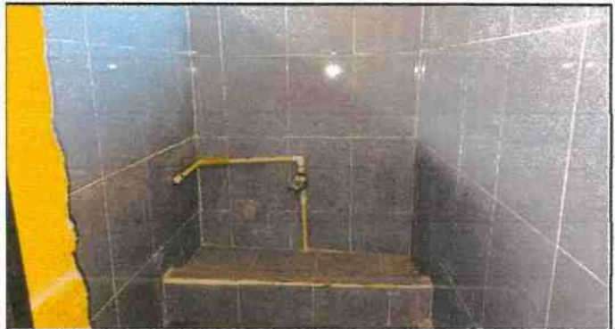
Foto 4: Suministro base de Concreto Para Mingitorio con azulejo en paredes
