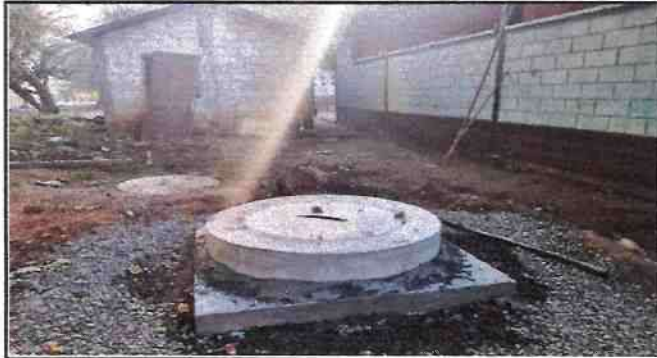
FOTO 1: SUSTITUCIÓN DE POZO DE ABSORCIÓN CON TUBO DE CONCRETO DE 90CM X 300CM DE PROFUNDIDAD
