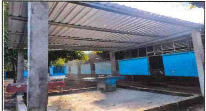
Foto 2: SUMINISTRO DE ESTRUCTURA DE METAL PARA EL ÁREA DE LA PILA, SUMINISTRO DE LAMINA TROQUELADA ALUZINC CALIBRE 26 AREA DE PILA
