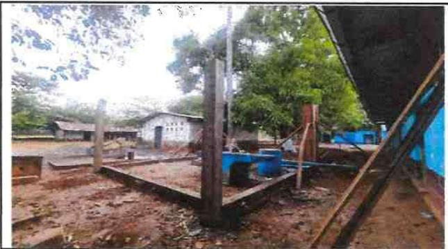
Foto 2: SUMINISTRO DE ESTRUCTURA DE METAL PARA EL AREA DE LA PILA, SUMINISTRO DE LAMINA TROQUELADA ALUZINC CALIBRE 26 AREA DE PILA
