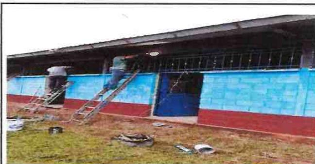
Foto 5: SUSTITUCIÓN DE BALCONES DE METAL POR METAL CON MEDIDAS 3.90CM DE ANCHO O.85 DE ALTO PARA AULAS. 2.50CM DE ANCHO 0.85CM DE ALTO PARA AULAS
