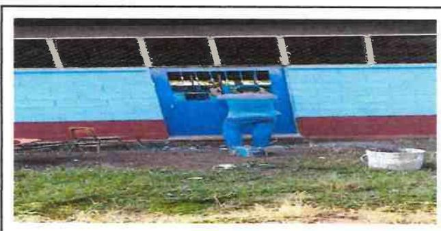
Foto 6: SUSTITUCIÓN DE PUERTAS DE METAL EN LAS AULAS DE 2.10 X 0.90
