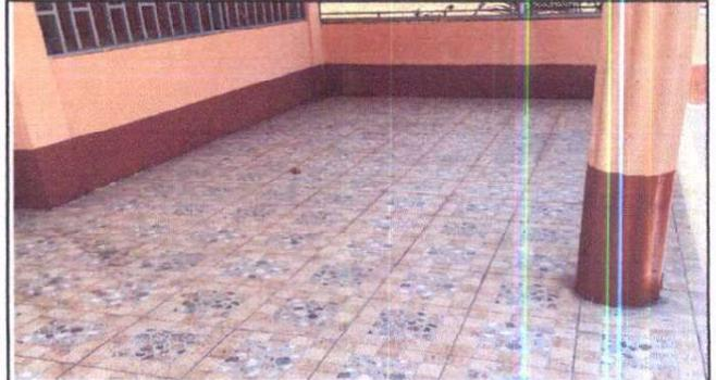
Foto 2: Colocación de piso ceramico antideslizante para la cocina y servicios sanitarios.
