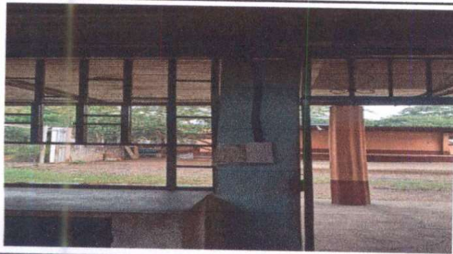
Foto 15: Suministro del sistema electrico de fuerza para el area de cocina
