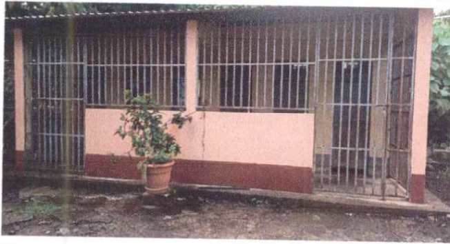
Foto 13: Mantenimiento de balcones de metal.
