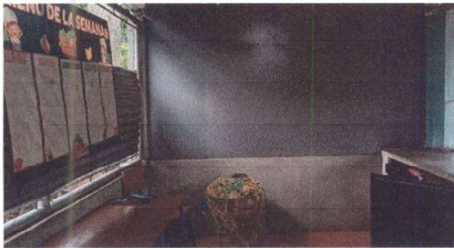
Foto 7: Suministro de pintura en muros interiores y exteriores para el área de cocina y servicios sanitarios
