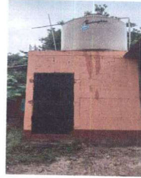
Foto 14: Suministro de base de concreto para instalacion de deposito de agua
