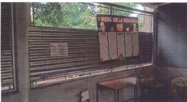
Foto 3: Sustitucion de malla galvanizada por muro de block en area de cocina
