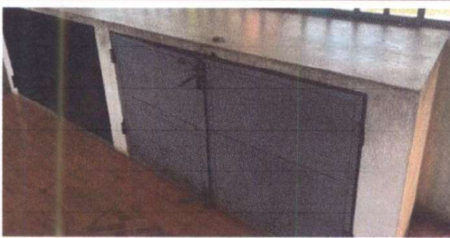
Foto 5: Suministro de puerta de pvc para gabinete de la cocina
