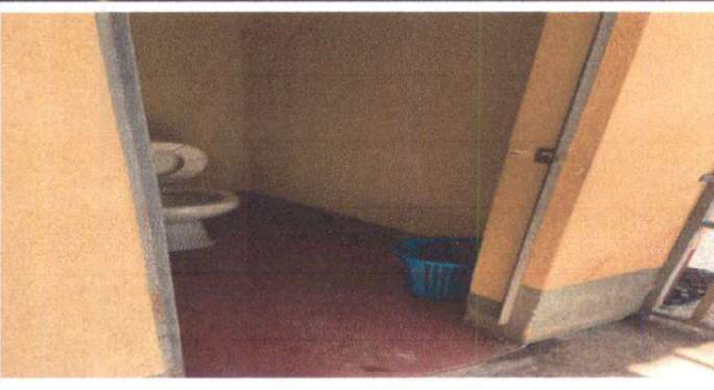
Foto 11: Suministro e instalación de azulejo para gabinete de la cocina y servicios sanitarios
