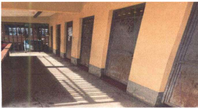
Foto 9: Suministro e instalación de piso cerámico antideslizante para la cocina y servicios sanitarios
