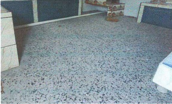
FOTO 1: SUSTITUCION DE PISO DE TORTA DE CONCRETO POR PISO DE GRANITO
