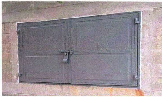
FOTO 7: SUSTITUCION DE VENTANA DE METAL POR VENTANA DE METAL DE DOS HOJAS 1.50 X 1.60 METROS
