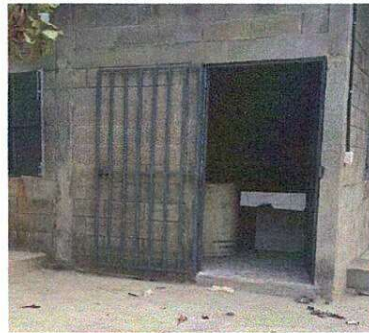
FOTO 8: MANTENIMIENTO A PUERTA REJA DE METAL 2 X 1 METROS
