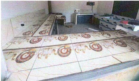
FOTO 9: SUMINISTRO DE AZULEJO PARA GABINETE DE COCINA
