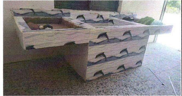
FOTO 10: SUMINISTRO DE PILA DE DOS LAVADEROS REVESTIDA DE AZULEJO (INCLUYE DRENAJE SANITARIO)
