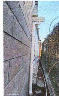
FOTO 12: SUMINISTRO DE CANAL DE METAL Y BAJADA DE AGUA PLUVIAL METROS
