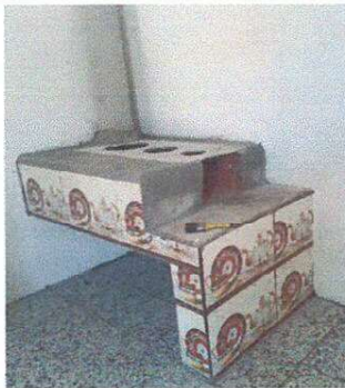
FOTO 3: SUSTITUCION DE PLANCHA DE METAL DE 3 HORNILLAS INCLUYE CHIMENEA 1.20 X 1 METRO
