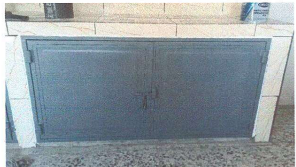
FOTO 6: SUMINISTRO DE PUERTA DE METAL PARA GABINETE
