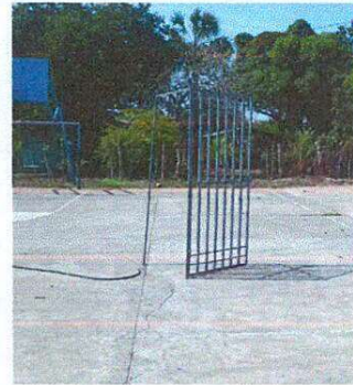
FOTO 8: MANTENIMIENTO A PUERTA REJA DE METAL 2 X 1 METROS
