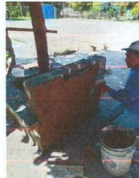
FOTO 16: SUSTITUCION DE LAVAMANOS
