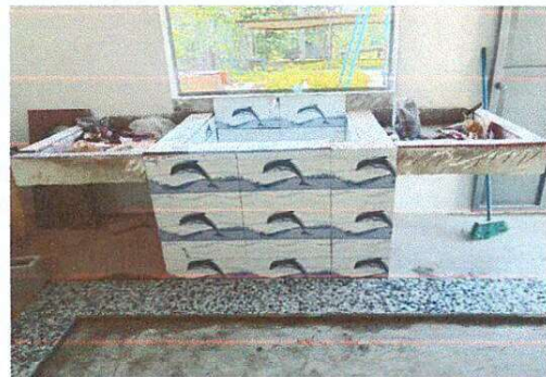
FOTO 10: SUMINISTRO DE PILA DE DOS LAVADEROS REVESTIDA DE AZULEJO (INCLUYE DRENAJE SANITARIO)
