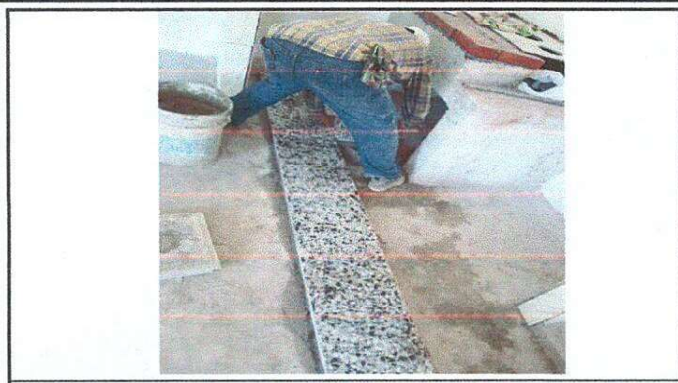
FOTO 1: SUSTITUCION DE PISO DE TORTA DE CONCRETO POR PISO DE GRANITO
