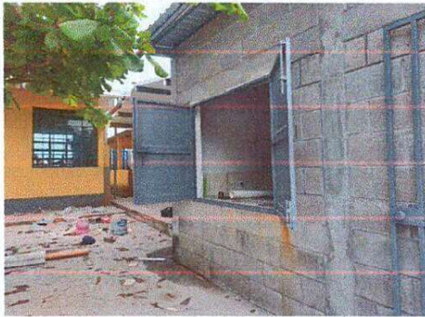
FOTO 7: SUSTITUCION DE VENTANA DE METAL POR VENTANA DE METAL DE DOS HOJAS 1.50 X 1.60 METROS
