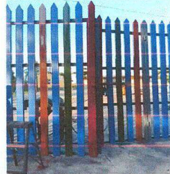
FOTO 20: MANTENIMIENTO A PORTON DEL METAL 4 X 2.25 METROS
