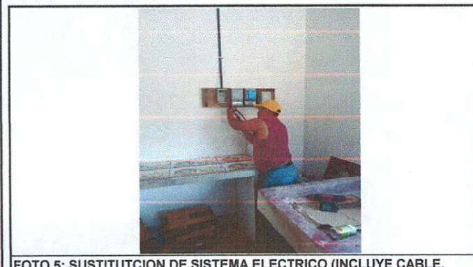
FOTO 5: SUSTITUCION DE SISTEMA ELECTRICO (INCLUYE CABLE, 4FOCO, 4 PLAFONES)
