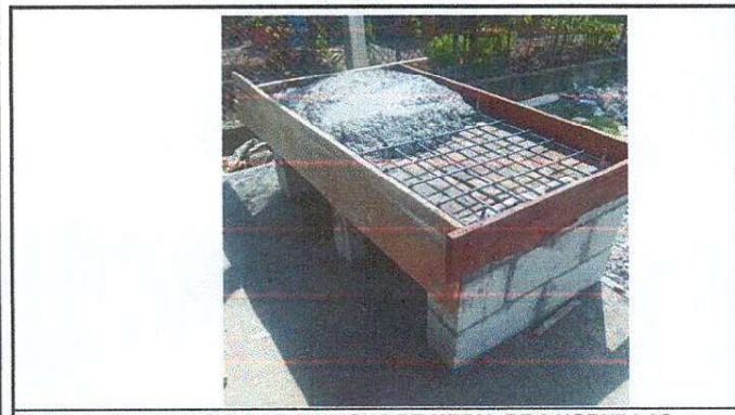
FOTO 3: SUSTITUCION DE PLANCHA DE METAL DE 3 HORNILLAS INCLUYE CHIMENEA 1.20 X 1 METRO
