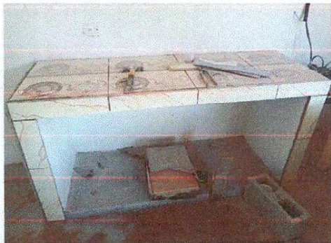
FOTO 9: SUMINISTRO DE AZULEJO PARA GABINETE DE COCINA
