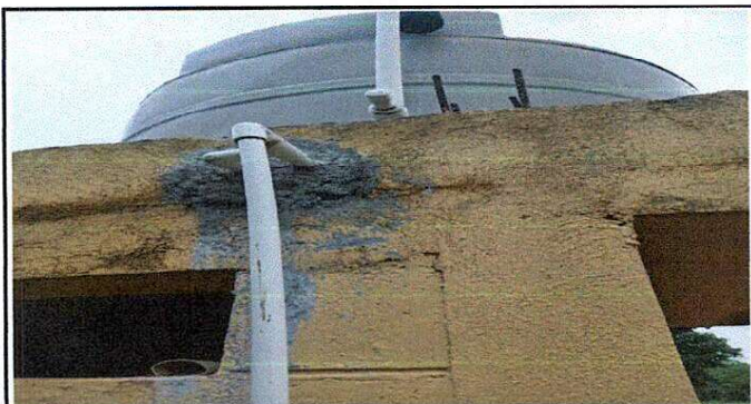
Foto 11: Suministro de Loza de Concreto.
