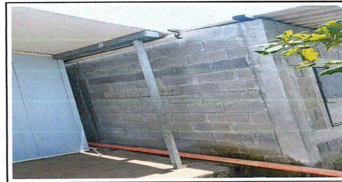
Foto 12: Suministro de Canal de Metal y bajada de Agua pluvial.
