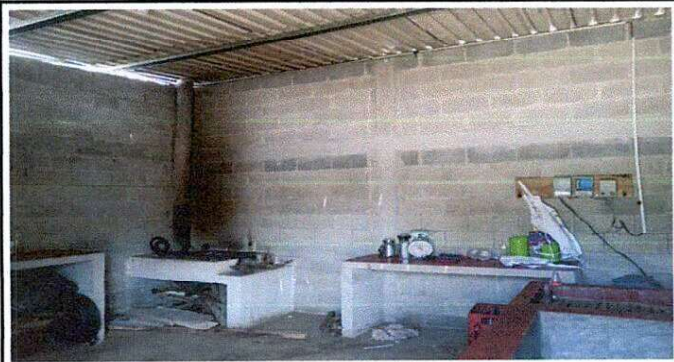
Foto 9: Suministro de Azulejo para gabinete de Cocina.
