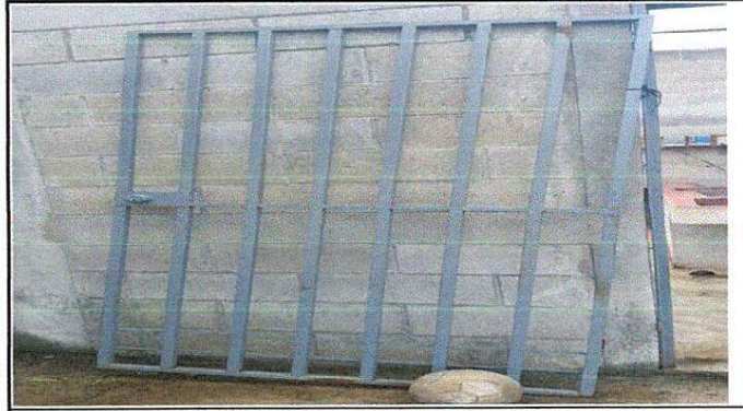
Foto 8: Mantenimiento de Puerta Reja de Metal.
