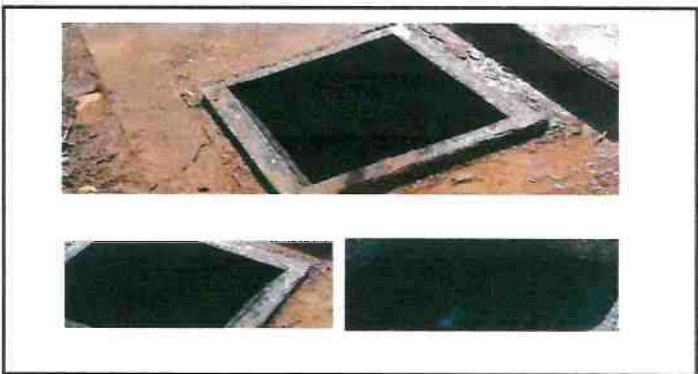
Limpieza de fosa septica.
