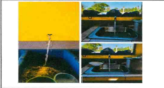
Reparación de red de drenaje y red de agua potable
