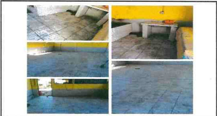
Piso / sustitución de torta de concreto por piso ceramico en cocina y aula.
