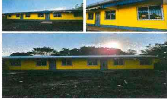
Pintura en muros interiores y exteriores.
