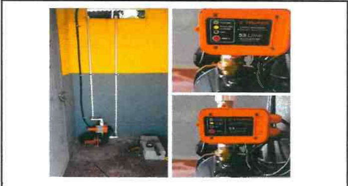
Reparación y mantenimiento de cisterna / depósito de agua.
