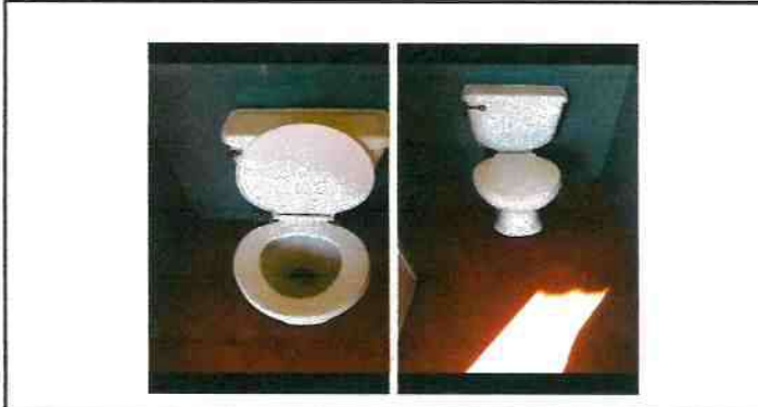
Servicios sanitarios / sustitución de inodoro y accesorios.
