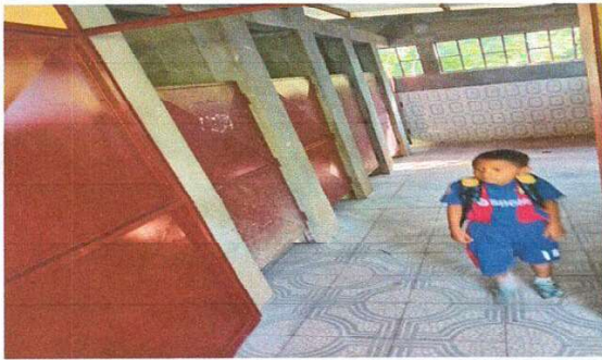
Foto1: Mantenimiento a estructura de puerta de metal, por metal.
