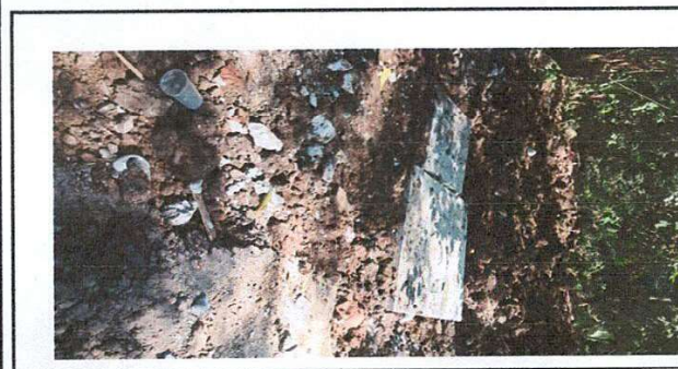
Foto 5: Sustitución de tubería PVC lineal principal de aguas negras
