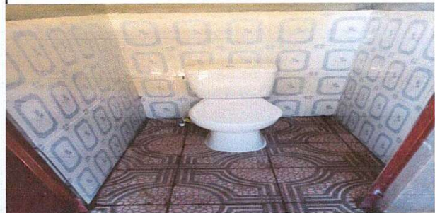
Foto 4: Sustitución de inodoros (incluye) sus accesorios.
