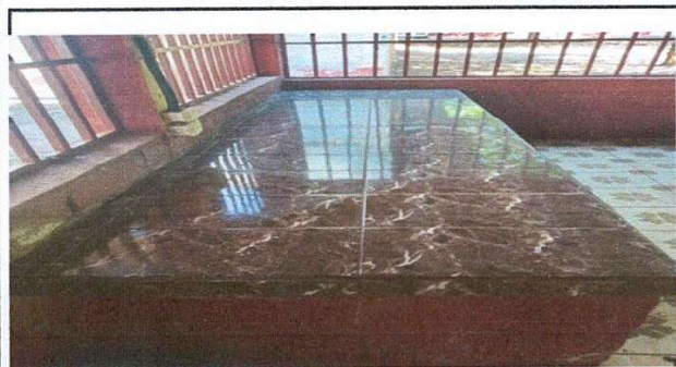
Foto 3: Reparación de azulejos en muebles de cocina.
