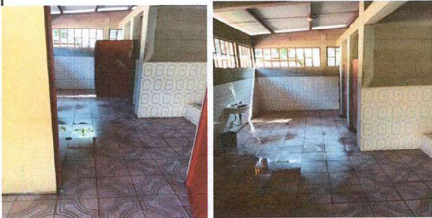
Foto 3: Sustitución de piso de granito, por piso cerámico antideslizante.
