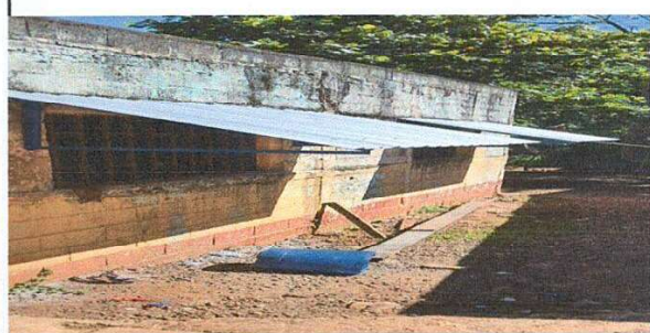
Foto 2: Sustitución de cubierta de lámina, por lámina troquelada aluzinc calibre 26
