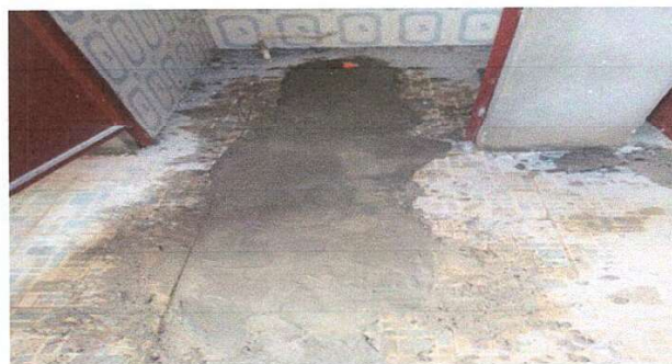
Foto 4: Sustitución de inodoros (incluye) sus accesorios.
