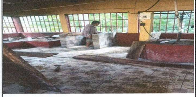
Foto 2: Plancha de concreto en cocina.
