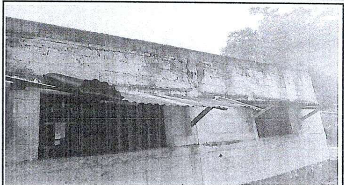
Foto 2: Sustitución de cubierta de lámina, por lámina troquelada aluzinc calibre 26
