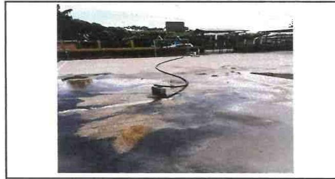
Foto 6: Sustrucción de bomba sumergible de 1 HP
