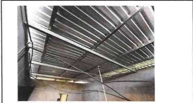
Foto 2: Sustrucción de estructura y lámina. Repello en bodega
