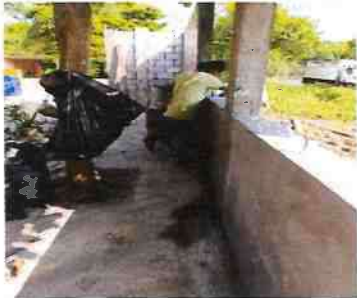
Foto 3. Levantado de muro perimetral
