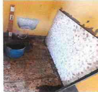
Foto 4. Instalación de azulejo en las paredes y cambio de inodoros
