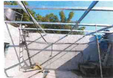
Foto 2. En bodega de cocina cambio de lámina, cambio de estructura y repello las paredes.
