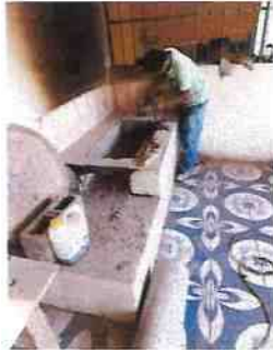
Foto 1. Cambio de plancha y chimenea
