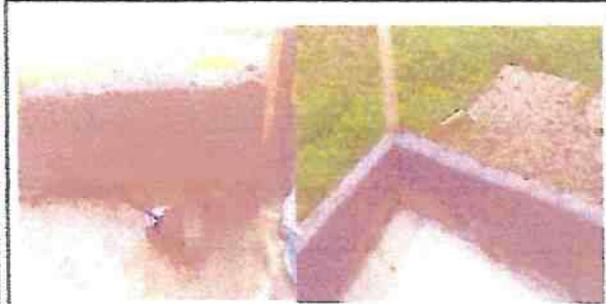
Las paredes del muro perimetral estan con grietas ya que no tiene cimiento adecuado ni columnas.
