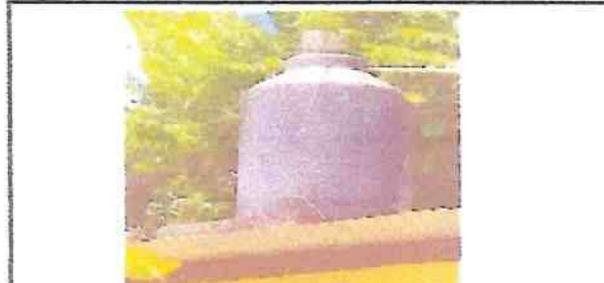
El depósito de agua está en mal estado y es insuficiente la cantidad que guarda
