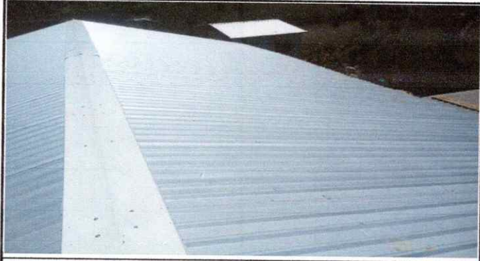
Foto 1: Sustitución de 184 metro de cubierta de lamina por lamina troquelada calibre 26 de la EORM.
