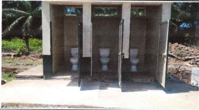
Foto1: Sustitución de de tasa de baño de chian.
