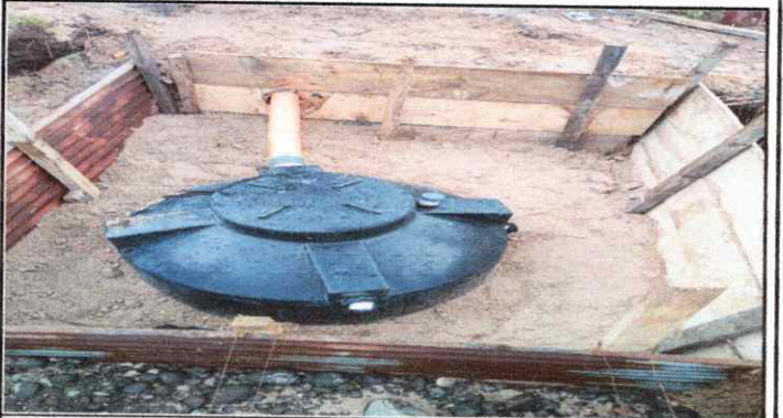
Foto 4: Sustitución de biodigestor.
