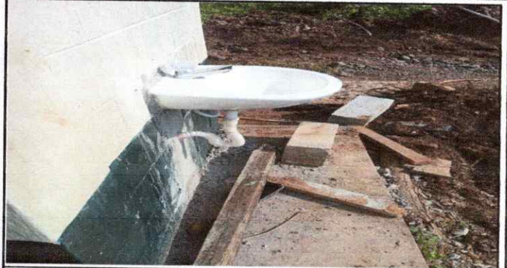
Foto 2: Sustitución de lavamano de concreto por lavamano de china.
