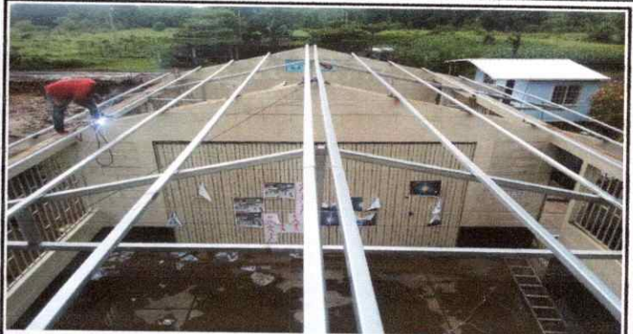
Foto 2: Sustitución de estructura de metal en aula de la EORM
