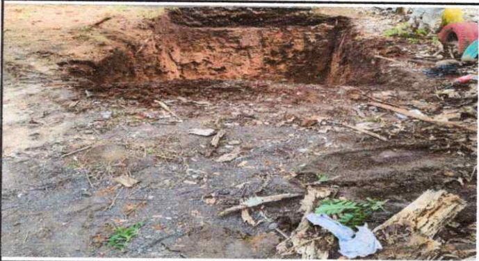
Foto 3: Sustitución de drenaje pluvial
