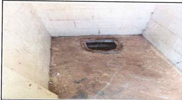
Foto 3: Sustitución de inodoros ciegos por inodoros lavables.
