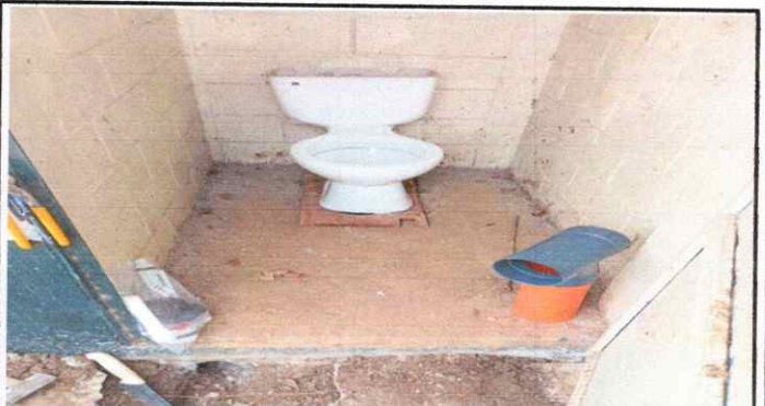
Foto 4: Sustitución de inodoros incluyen accesorios de los banos de la EORM.
