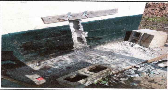
Foto 5: Instalación de lavamano.
