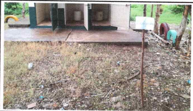
FOTO 4: Sustitución de biodigestoreo.
