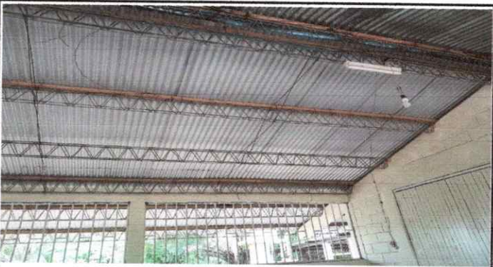
FOTO 3: Sustitución del techo de la EORM
