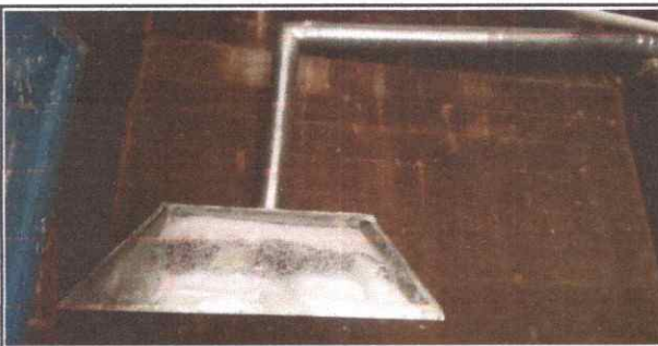
Foto 5: Sustitución de chimenea en cocina.
