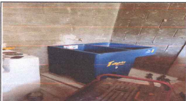
Foto 3: Sustrucción de pila de concreto por pila de plastico con sus sistema de drenaje que son 75 metros de tubería PVC.
