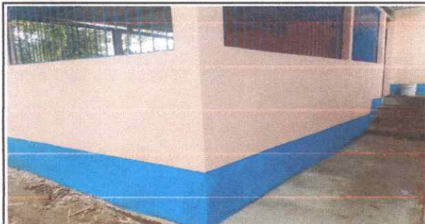
Foto 6: Sustitución de pintura de 70 metros cuadrado.
