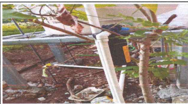
Foto 3: Sustitución de Rotoplas con todo su instalación.
