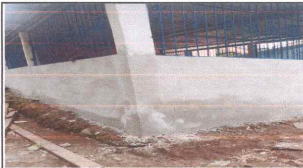
Foto 4: Sustitución de repello de 70 metros cuadrado de aula de la EORM.
