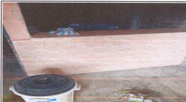
Foto 1: Sustrucción de 7 metros de azulejo.
