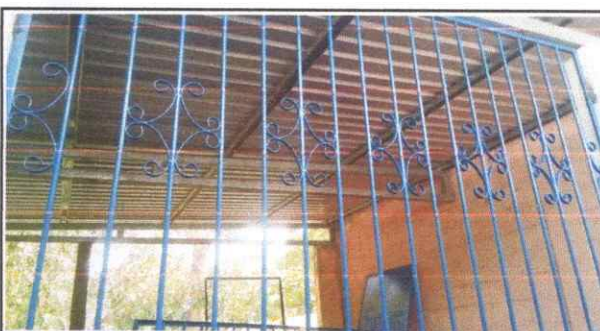
Foto 4: Sustrucción de 24 metros de balcon de la aula de la EORM.
