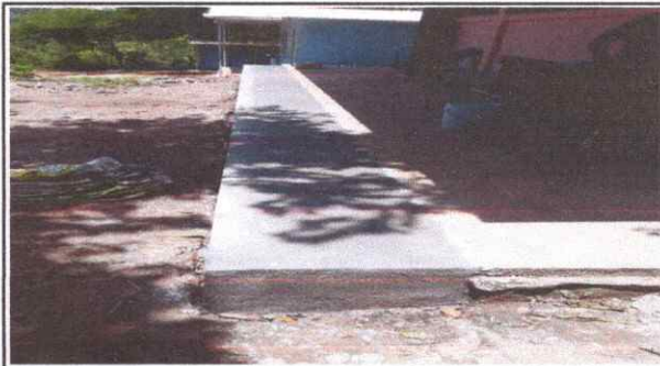
Foto 2: Sustitución de 24 metros cuadrado de banqueta de concreto.
