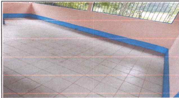
Foto1: Sustitución de 43 metros de piso antideslizante.
