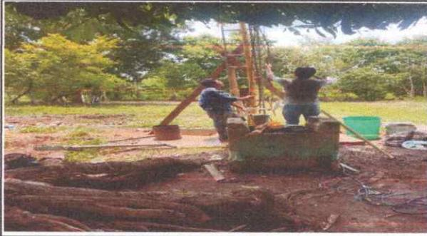
Foto 1: Sustitución por de bomba de agua 0.5 monofásico 11/12hp en pozo de la EORM.
