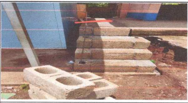
Foto 6: Sustitución de grada de la EORM.
