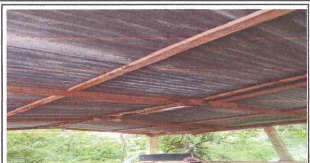
FOTO 1: Sustitución de pecho de aula de la EORM.
