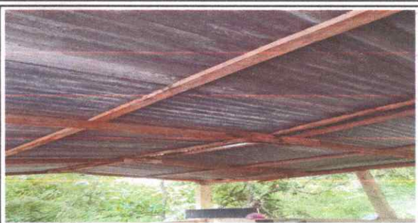
FOTO 2: Sustitución de madera por metal.
