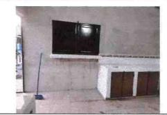
Foto 3: instalación de piso y azulejo en el mostrador de la ventana
