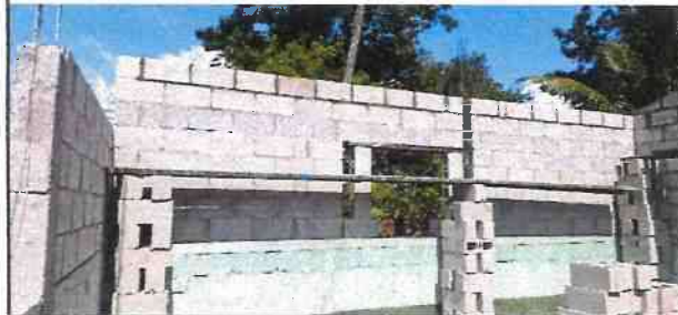
Foto 3: Bases de columna listas para fundir con cemento
