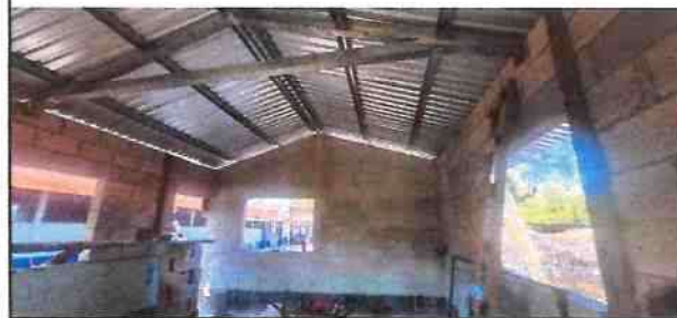
Foto 5: inicio del repello de paredes
