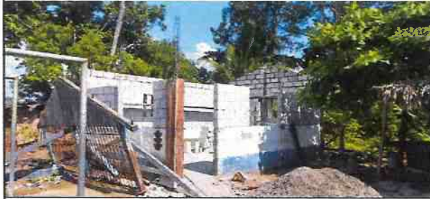
Foto 1: levantado de paredes y fundición de Columnas
