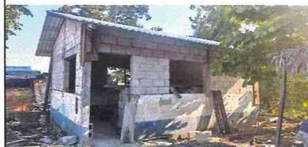
Foto 6: espacio de ventanas y listo para iniciar gabinetes
