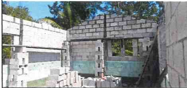
Foto 2: Levantado de paredes y bases para las columnas
