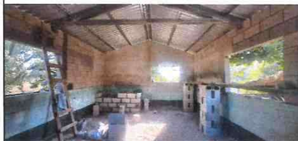
Foto 4: instalación de lámina e inicio de la pila
