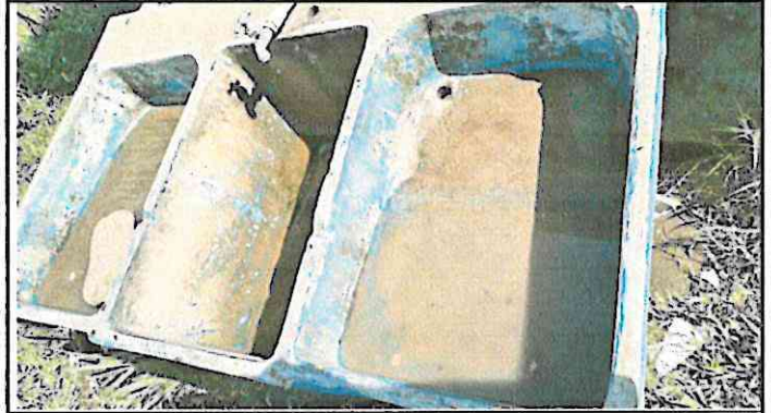
Foto2: Sustitución de pila de cemento de dos lavadero, mas torta de cemento
