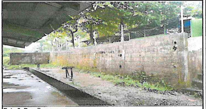
Foto 6: Repello en muro
