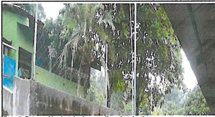
Foto 5: Reparación de tubo hg y malla galvanizada
