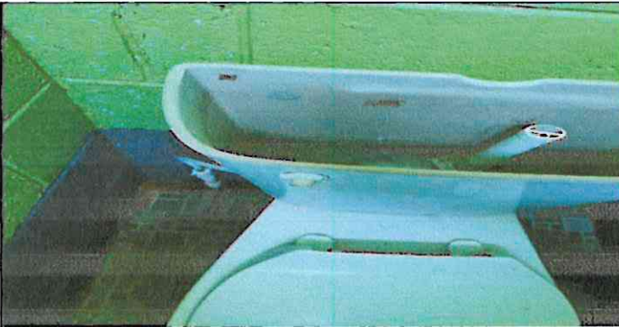
Foto 3: Sustitución de accesorios inodoro
