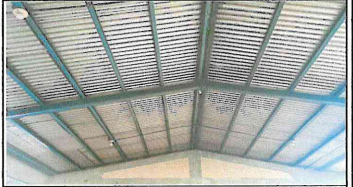
Foto 2: Mantenimiento a estructura de soporte de metal
