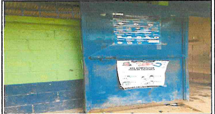
Foto 4: Mantenimiento de puertas
