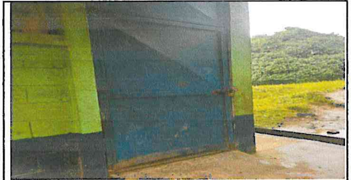
Foto 4: Mantenimiento de puertas
