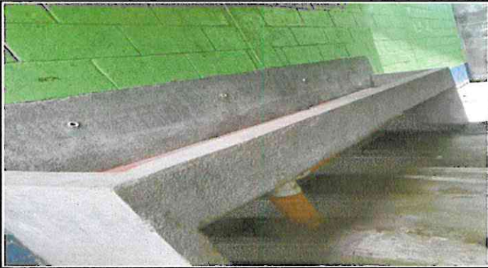
Foto1: instalación de chorros
