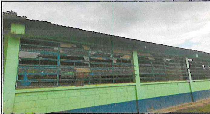
Foto 3: Mantenimiento a estructura de metal de ventana
