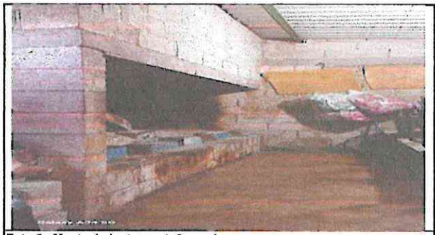
Foto 6: Mantenimiento a estufa rural
