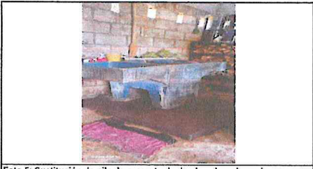
Foto 5: Sustrucción de pila de cemento de dos lavadero de cocina
