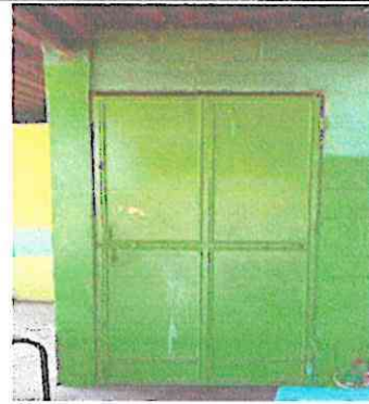
Foto 2: Sustitución de puerta de cocina
