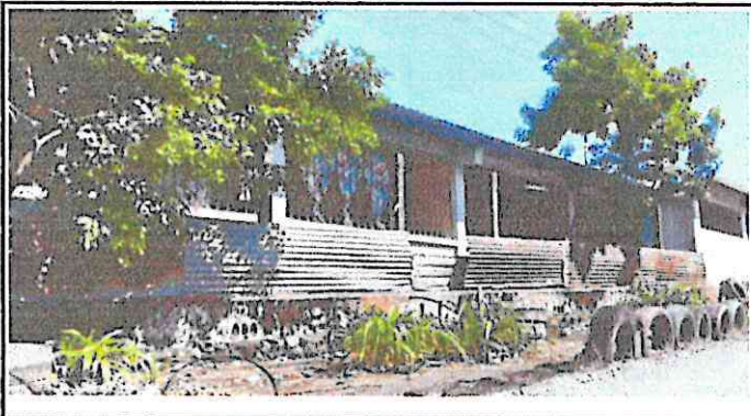
Foto 3: Reparación de Muro perimetral de Block
