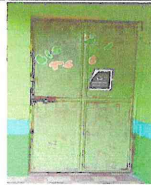
Foto 4: Sustitución de puerta de aulas
