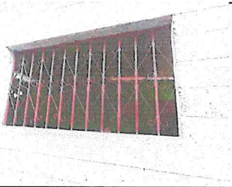
Foto 5: sustitución de balcones
