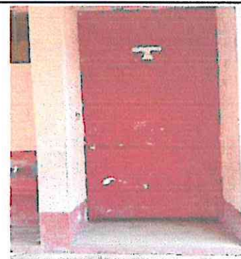
Foto 4: Sustitución de puerta de baños
