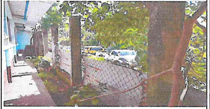
Foto 2: Reparación de Muro perimetral de Block
