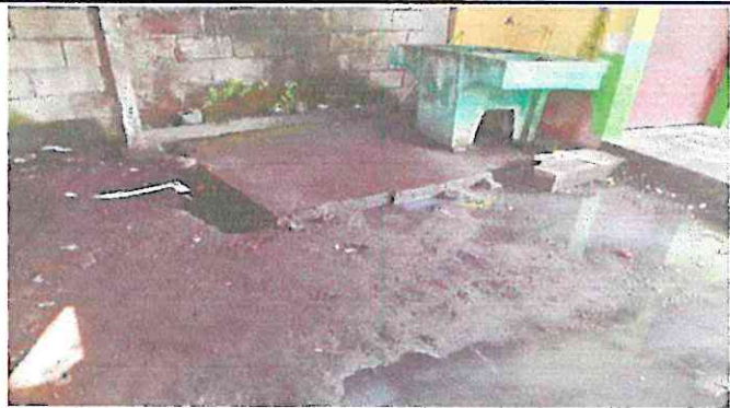
Foto 3: Mantenimiento fosa séptica
