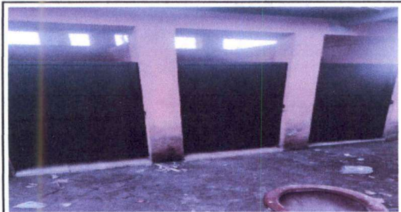
Foto 5: MANTENIMIENTO A ESTRUCTURA DE PUERTA DE METAL EN SERVICIOS SANITARIOS DE MODULO 2
