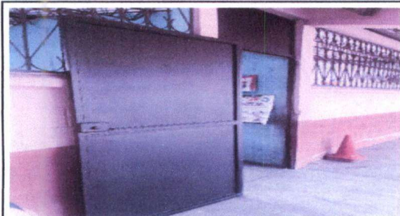
Foto 3: MANTENIMIENTO A ESTRUCTURA DE PUERTA DE METAL Y CAMBIO DE CHAPA EN AULAS DEL MODULO 2
