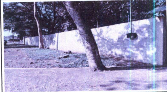
Foto 2: REPARACION DE REPELLO Y CERNIDO EN PARED DE MURO PERIMETRAL MODULO 1
