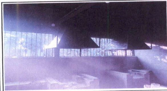
Foto 5: INSTALACION DE DOS CHIMENEAS DE ESTUFAS RURALES.
