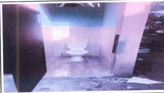
Foto 3: SUSTITUCION DE SANITARIOS COMPLETOS E INTALACION DE PISOS Y AZULEJOS MODULO 1
