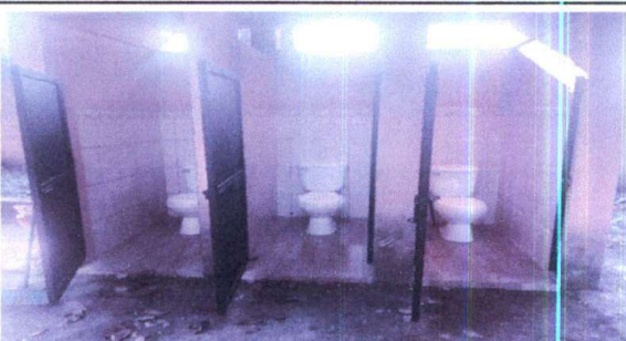
Foto 4: SUSTITUCION DE SANITARIOS COMPLETOS E INTALACION DE PISOS Y AZULEJOS MODULO 2
