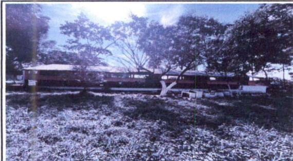
Foto 1: PINTURA EN MUROS DE INTERIOR Y EXTERIOR MODULO 2
