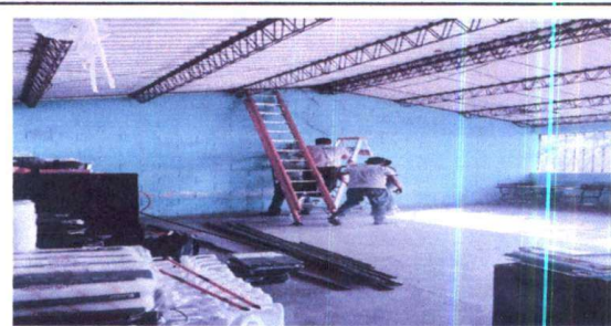
Foto 6: REPARACION DE SISTEMA ELECTRICO MODULO 2
