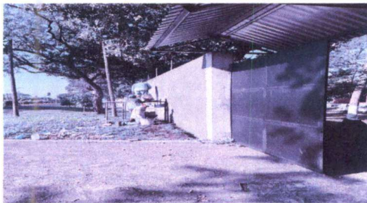
Foto 3: REPARACION DE REPELLO Y CERNIDO EN PARED DE MURO PERIMETRAL.
