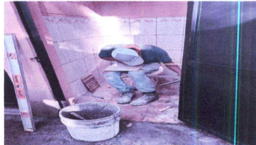
Foto 2: SUSTITUCION DE SANITARIOS COMPLETOS E INTALACION DE PISOS Y AZULEJOS MODULO 2
