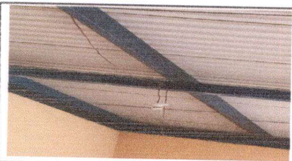
Foto 5: Sustitución de focos ahorradores
