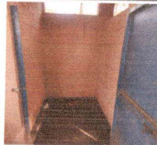
Foto 6: sustitución de torta de concreto por piso ceramico e instalación de azulejo en sanitarios
