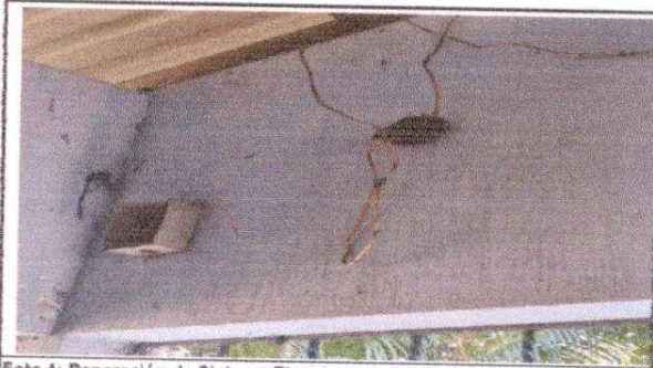
Foto 4: Reparación de Sistema Elctrico
