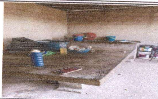
Foto 2: Sustitución de torta de concreto por piso cerámico, instalación de azulejo en mueble de cocina y pila de cemento artesanal
