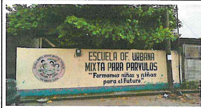
RECONSTRUCCIÓN DE FACHADA
