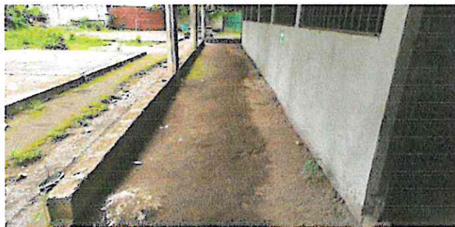
SUSTITUCIÓN DE PISO
