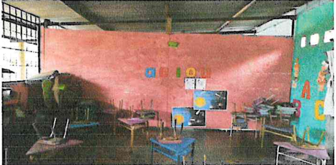
CONSTRUCCIÓN DE DIVISIÓN
