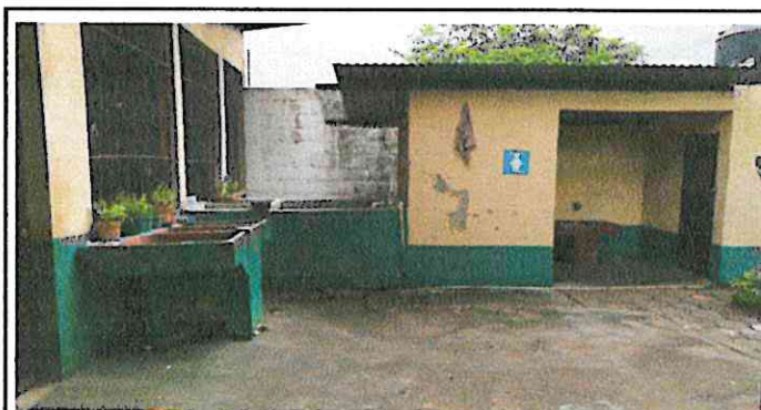
RECONSTRUCCIÓN DE REPELLO
