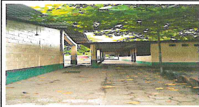
RECONSTRUCCIÓN DE FACHADA
