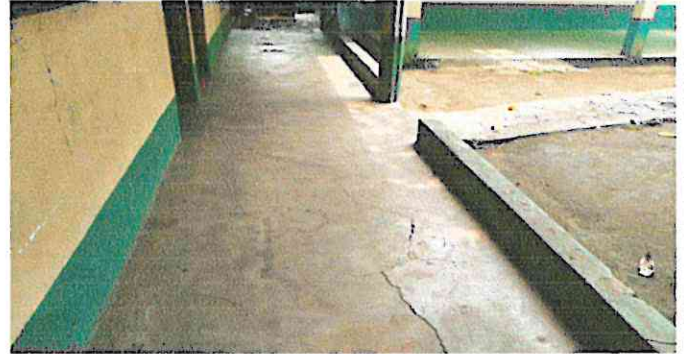
SUSTITUCIÓN DE PISO DE CONCRETO
