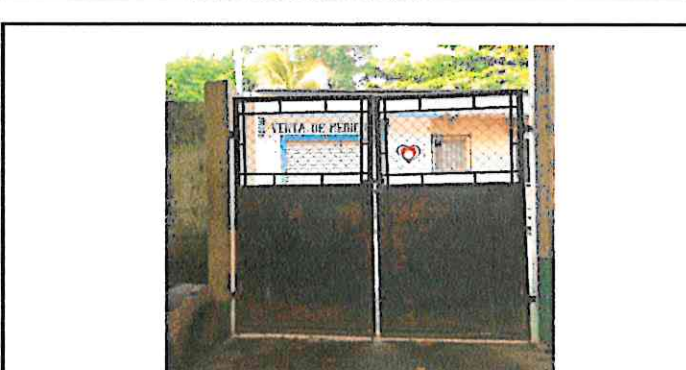
MANTENIMIENTO DE PORTON
