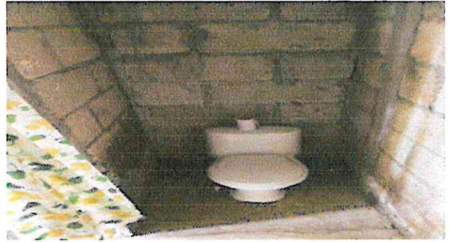
SUSTITUCIÓN DE REPELLO
