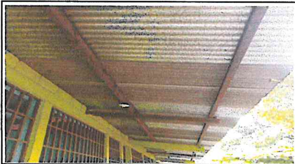
Foto 3: Sustitución de estructura de metal corredor principal.
