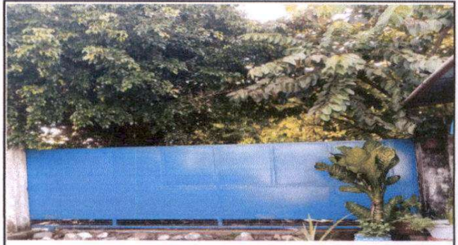
Foto 2: sustitución de porton de entrada No. 2
