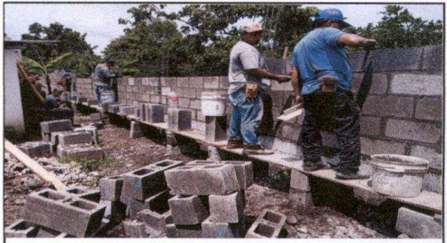
Foto 2: reparación de muro perimetral de block
