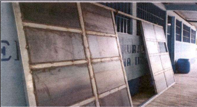
Foto 3: Fabricación de porton entrada principal 1
