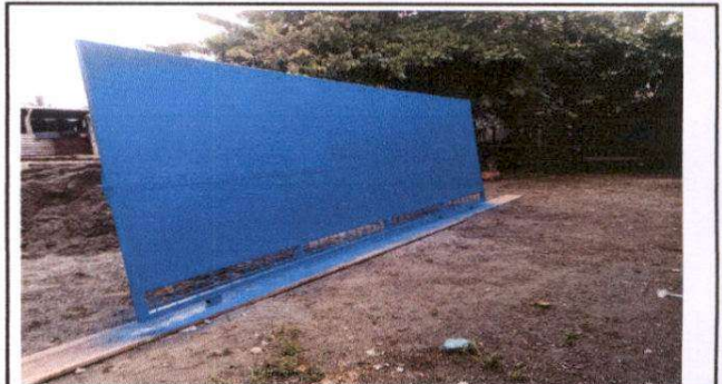
Foto 4: Fabricación de porton entrada principal 2
