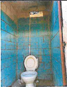
Foto 5: instalación de azulejo en baños
