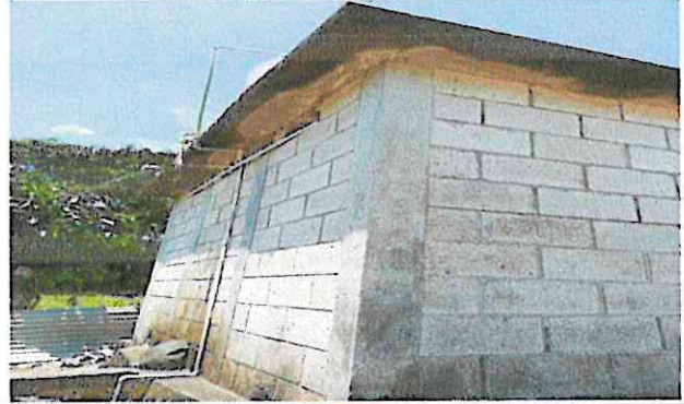
Foto 2: Repello en muro de baños
