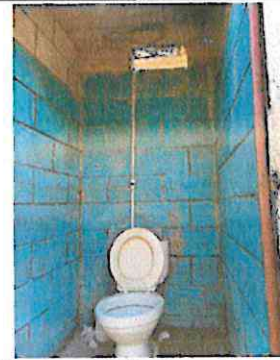
Foto 6: Pintura en muros exteriores e interiores de baños
