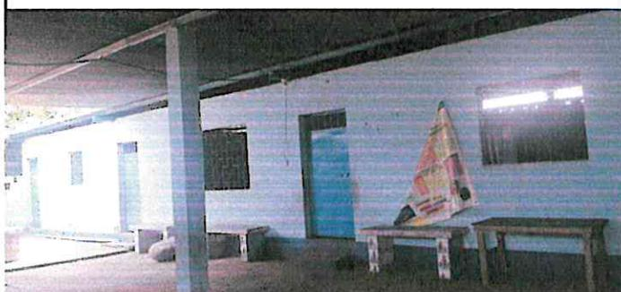
Foto1: Mantenimiento de puertas ventanas ,balcones de metal (lijado aplicación de 2 manos de pintura anticorrosiva color azul). Y sustitucion de pasadores de hierro liso por chapa yale.
