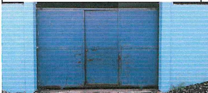
Foto 5: Mantenimiento a porton (lijado y aplicación de pintura anticorrosiva color azul)
