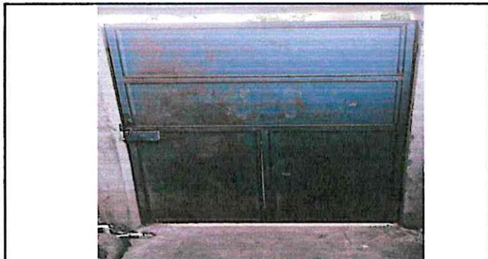
Foto 3: Mantenimiento de puertas (lijado aplicación de 2 manos de pintura anticorrosiva, color azul).
