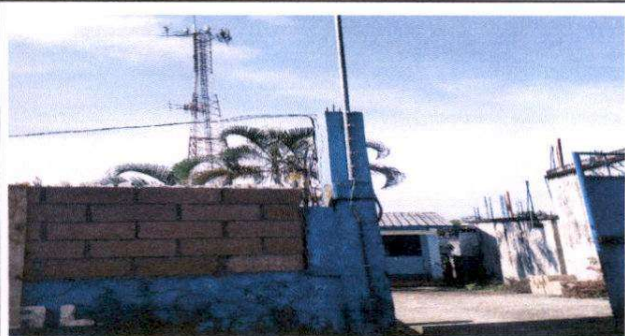
reparación del sistema eléctrico
