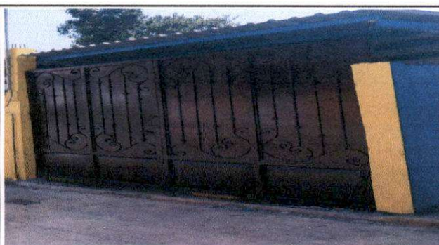
reparación de porton de ingreso.
