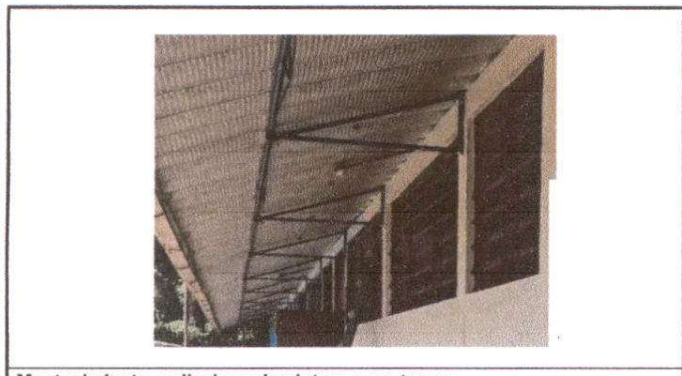
Mantenimiento, aplicaicon de pintura a ventanas
