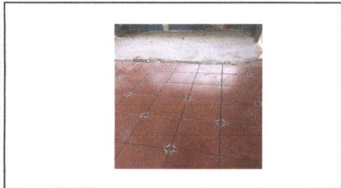
Colocación de piso ceramico.
