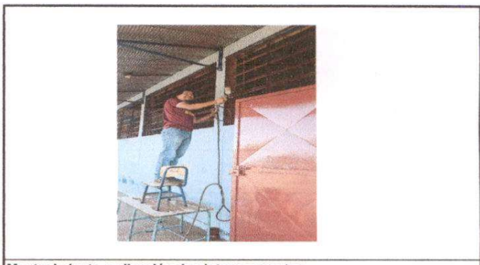
Mantenimiento, aplicación de pintura a puertas.
