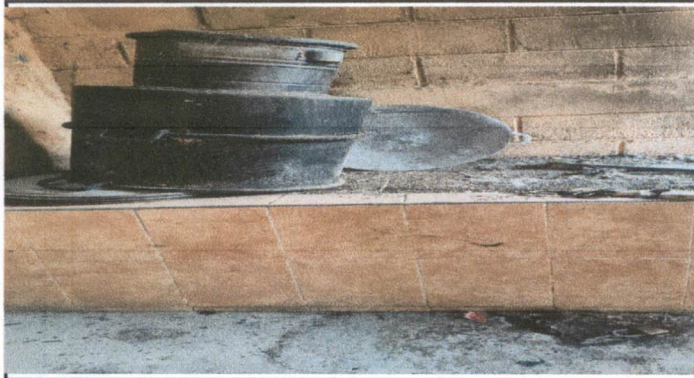
Foto1: Remodelación de Poyetón con chimenea
