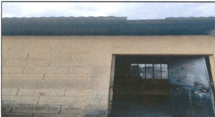
Foto 3: Cambio de Puera Cocina
