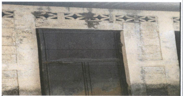
Foto 6: Repello y cambio de lámina sanitarios
