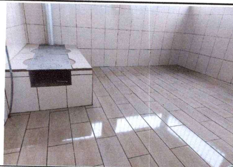
Foto 6: Sustitución de estufa rural (completa) incluye chimenea y plancha de metal y sustitución de piso de concreto por cerámico.
