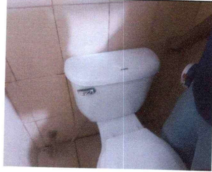
Foto 2: Sustitución de accesorios en inodoro
