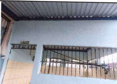
Foto 5: Cubierta de lámina, sustitución de estructura de madera por metal, sustitución de pintura, sustitución de balcones de metal por ventanas PVC, sustitución de pila por pila rural.
