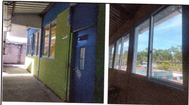
Foto 4: Mantenimiento a estructura de puertas y sustitución de ventanas de metal con vidrio por ventanas de PVC
