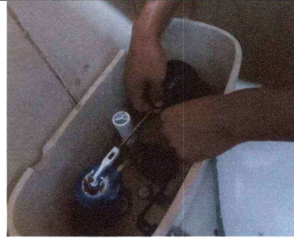
Foto 2: Sustitución de accesorios en inodoro
