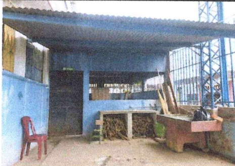
Foto 5: Cubierta de lámina, sustitución de estructura de madera por metal, sustitución de pintura, sustitución de balcones de metal por ventanas PVC, sustitución de pila por pila rural.
