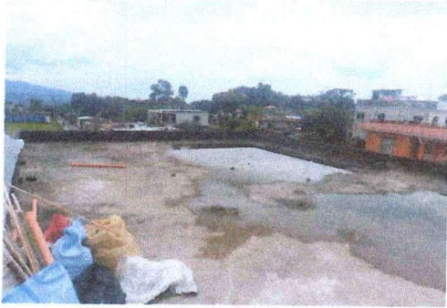
Foto1: Impermeabilización de losa
