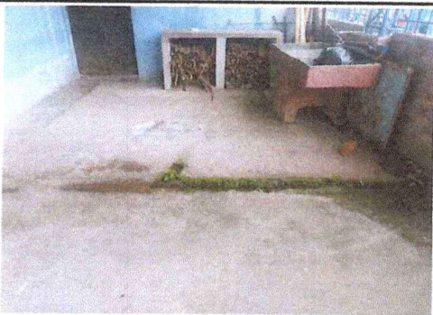
Foto 3: Reparación de red de drenaje (sustitución de rejilla de aguas pluviales)
