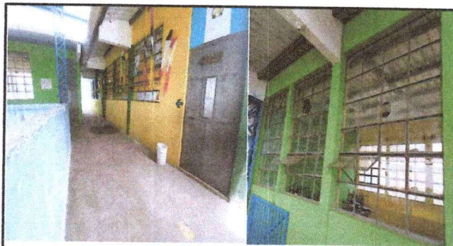
Foto 4: Mantenimiento a estructura de puertas y sustitución de ventanas de metal con vidrio por ventanas de PVC
