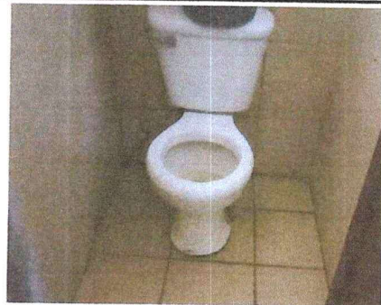
Foto 2: Sustitución de accesorios en inodoro
