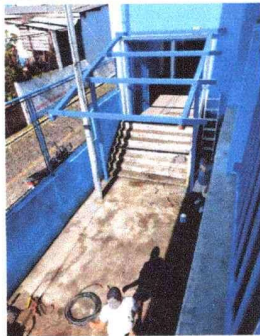
Techado de ingreso a Cancha escolar
