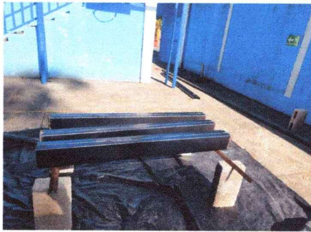
Ampliación de techo sobre sanitarios, Módulo Norte
