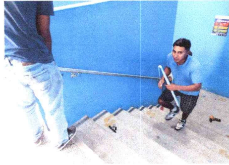
Pasamanos en graderío, Módulo sur
