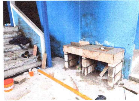
Construcción de 2 lavamanos, Módulo Sur
