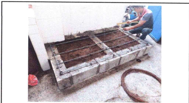
Construcción de cocina rural con hornillas, cocina escolar, módulo sur
