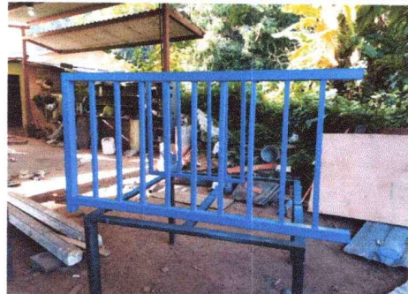
Cambio de tope de ingreso en portón Principal, módulo norte
