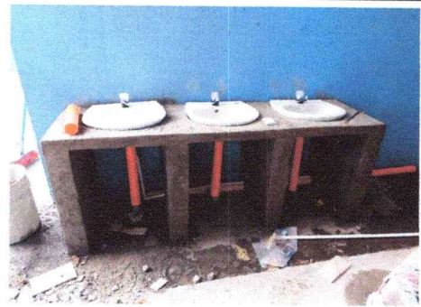
Construcción de 3 lavamanos, módulo Norte
