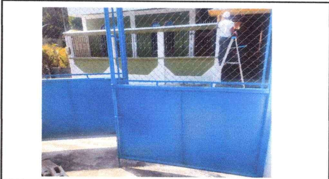
Mantenimiento de Portón principal, lijado y pintura, Módulo sur
