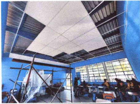
Cielo falso de aulas, módulo sur
