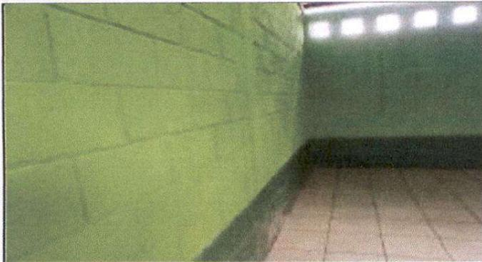
Foto1: Foto1: Sustitucion de piso de concreto por piso de ceramico
