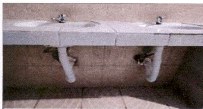
Foto 5: Suministro de cifón para lavamanos existentes
