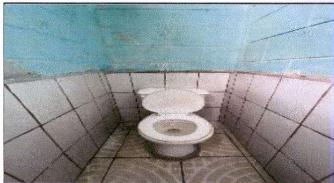
Foto 4: Suministro de 6 sanitarios color blanco
