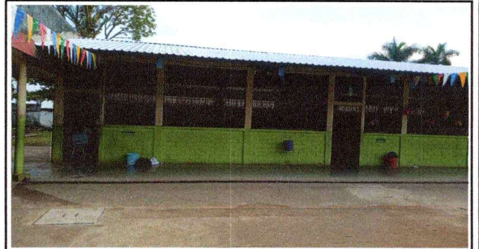
Foto 4: Techo de dos aulas que fue sustituido.
