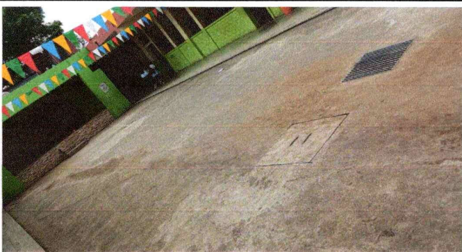
Foto 3: Trayecto de drenaje que fue sustituido.
