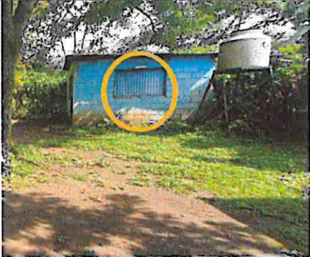
Foto 1: Sustrucción de ventanas de lámina por ventana de metal.
