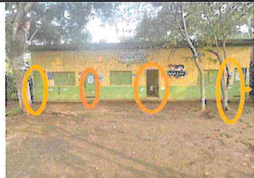
Foto 4: Sustrucción de puertas de madera por metal.
