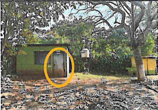
Foto 3: Sustrucción de puerta de madera por metal de la cocina.
