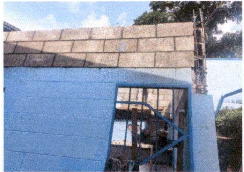
Foto 2: Sustitución de ventanas de metal por ventanas de PVC y fabricación de balcones de metal.
