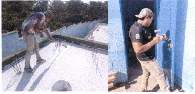
Foto1: Imperbeabilización en terraza y sustitución de chapas en puertas
