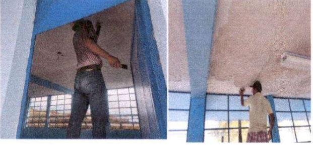
Foto 5: Cernido en techo de módulo de aulas y reparación de sistema eléctrico.
