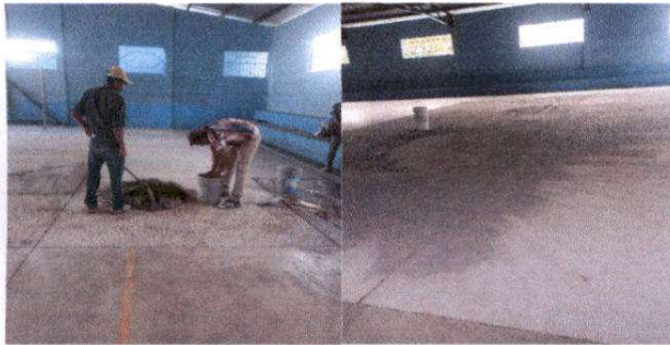
Foto 3: Aplicación de pintura en cancha polideportiva y reparación de plancha de concreto de patio.
