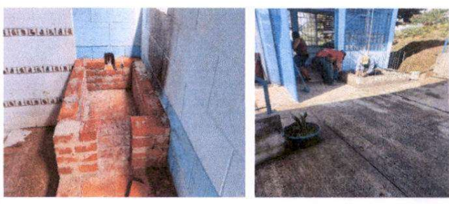
Foto 6: Sustitución de estufa rural, pila y levantado de mampostería de block en cocina.
