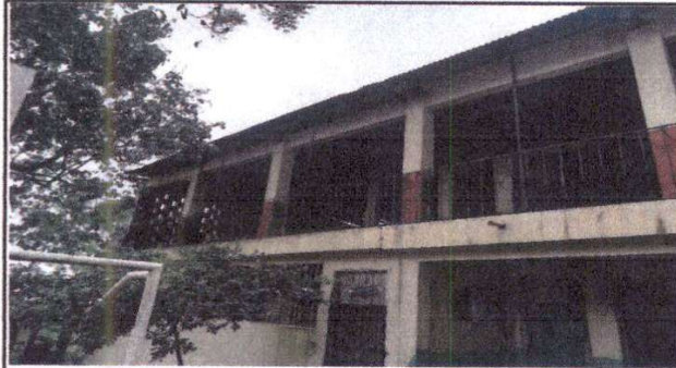
Foto1: Cubierta de lamina Módulo 1 del segundo nivel aula 1 y corredor
