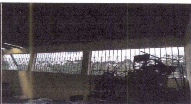
Foto 5: VENTANAS Módulo 1 del segundo nivel aula 1.
