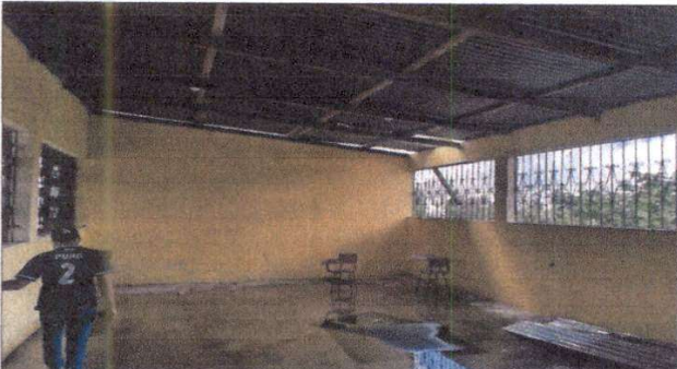
Foto 3: Sustitución de estructura de soporte de madera por metal en aula
