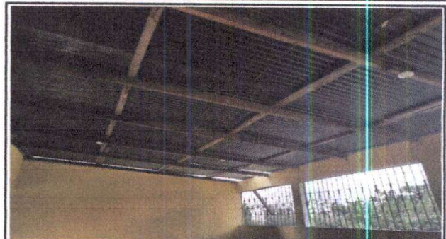
Foto 2: Estructura de Techo Módulo 1 del segundo nivel aula 1 y corredor
