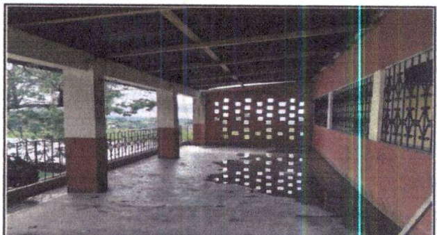
Foto 4: Sustitución de estructura de soporte de madera por metal en corredor
